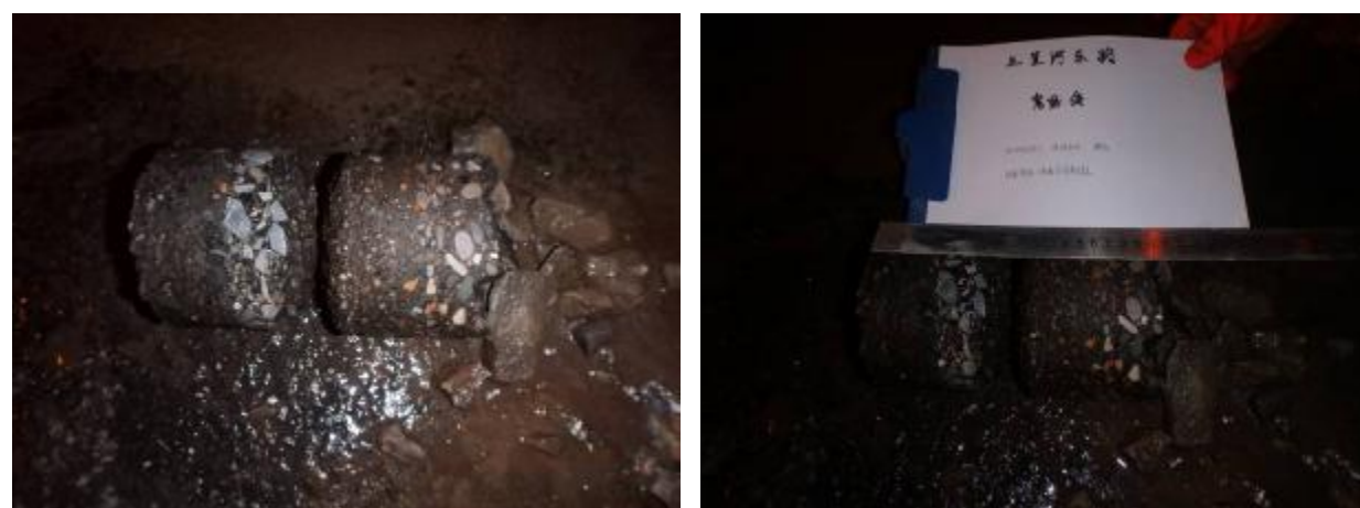
完好处取芯：4+6+10cm沥青面层+级配碎石
