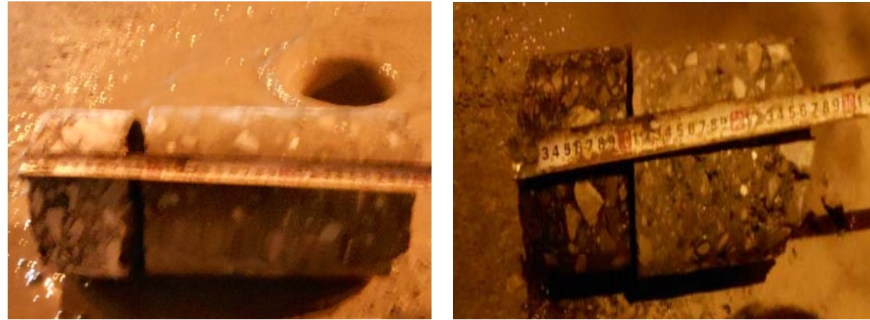
现场钻芯取样图
